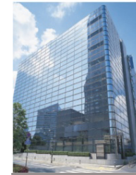
Tokyu Sakuragaoka-cho Bldg.
