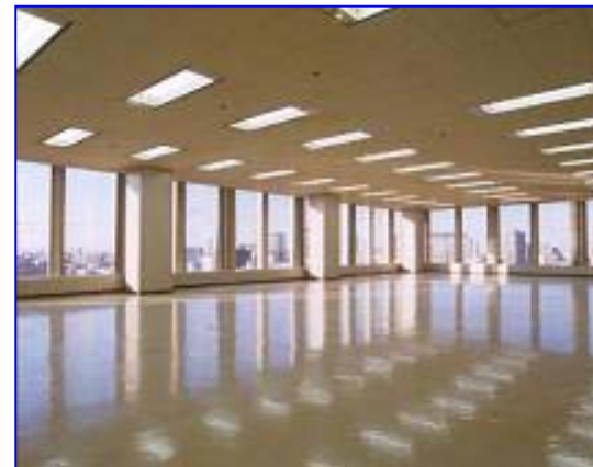
リニューアル工事前のオフィススペース
